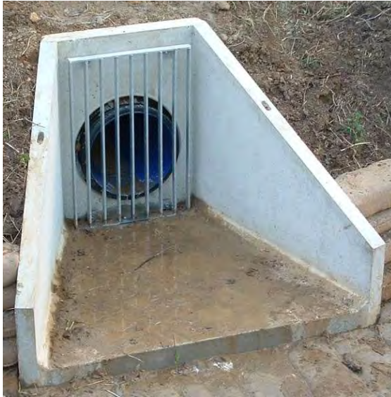
Figur 47. Betongkonstruktion omkring inlopp till dagvattenledning (Engineeringdiscoveries, 2025)
