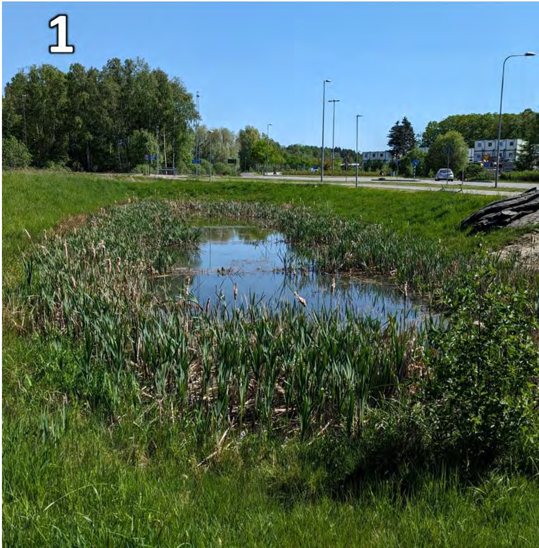
Figur 57. Råvebergsvägens norra damm (Foto: Petter Mogenfelt)
