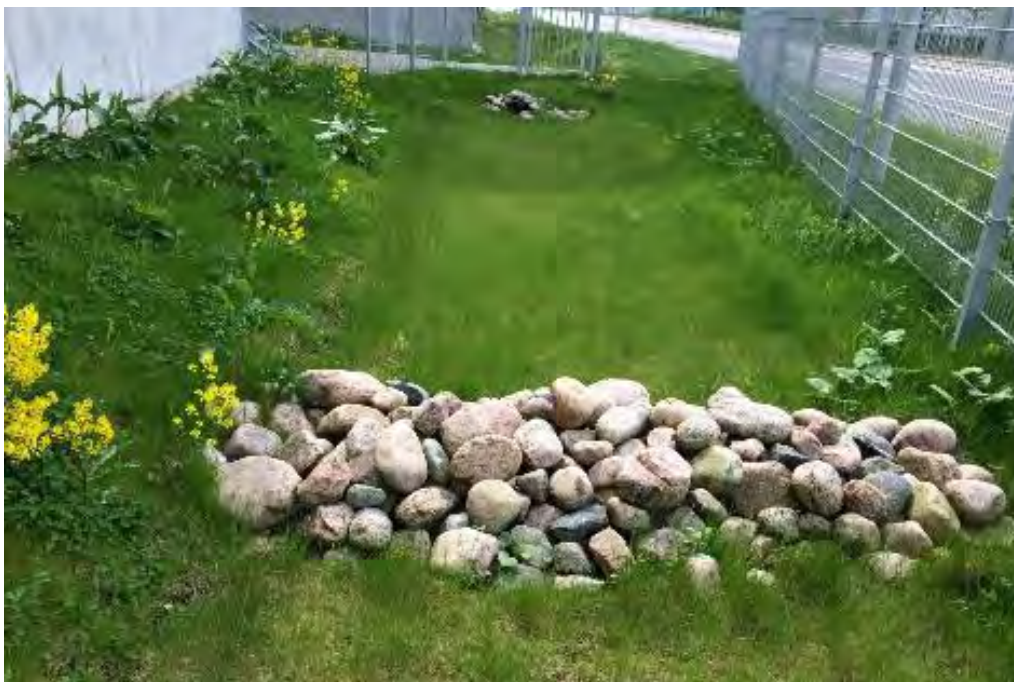
Figur 34. Svackdike med dämmande stenvall på Alelyckan, Göteborg (Foto: Kretslopp och vatten)
