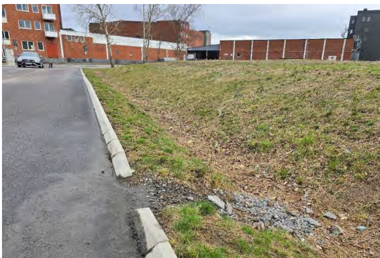
Figur 38. Dike omkring parkering i Göteborg, med öppning i kantsten och erosionsskydd (Foto: Petter Mogenfelt)
