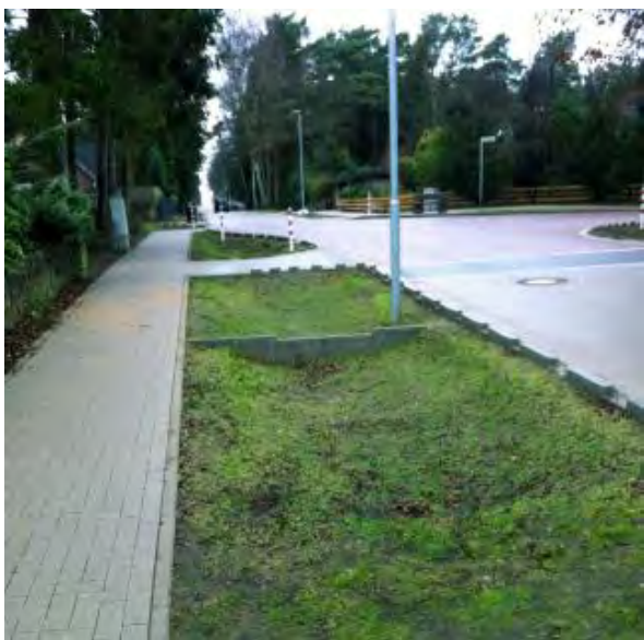
Figur 37. Mindre dike utmed gata (Foto: WRS)
