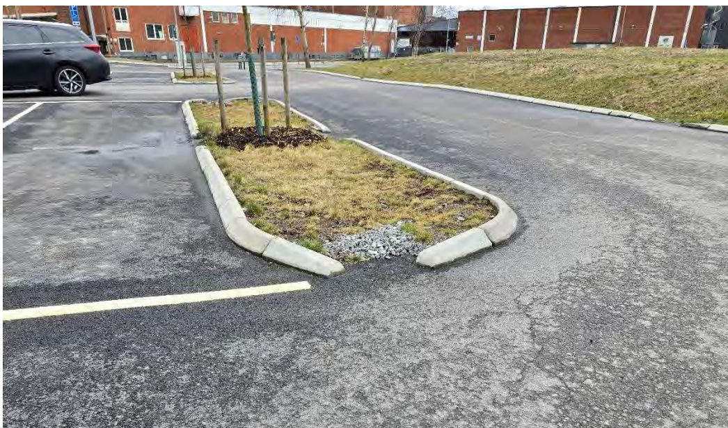
Figur 41. Växtbädd på parkering i Göteborg, med öppning i kantsten och erosionskydd (Foto: Petter Mogenfelt)
