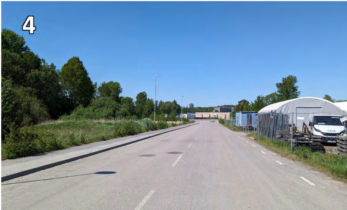
Figur 52. Befintlig väg inom Delområde B, Gunnareds industriväg (Foto: Petter Mogenfelt)
